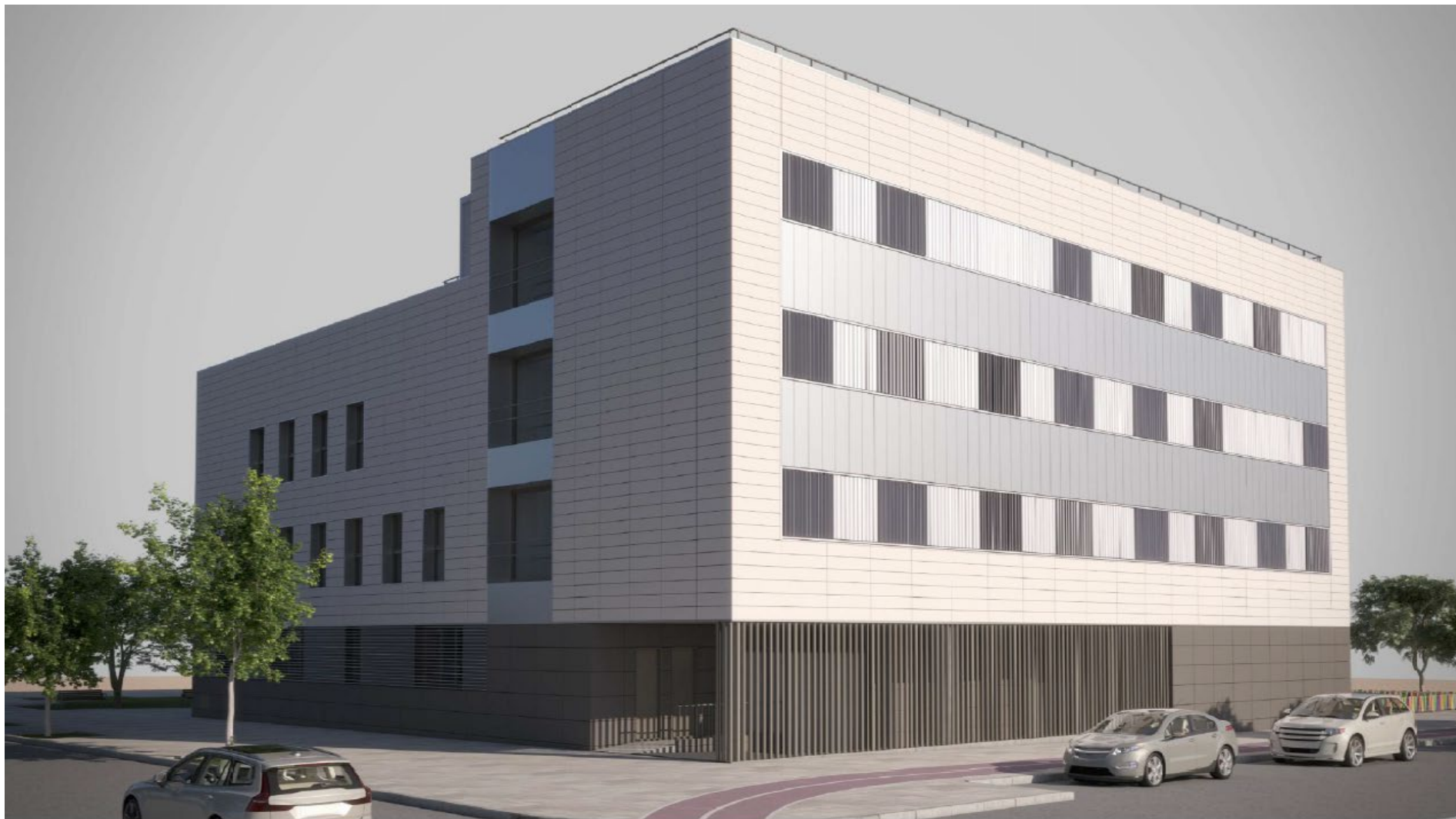
VISTA NOROESTE Desde cruce de calle Aragón y Zacarías Martínez
